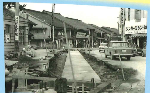
町用水の暗渠化工事写真 (昭和41年) 越前市蔵
